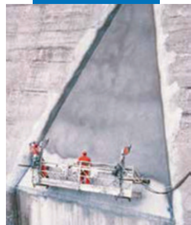
Нанесение Mapelastick на дамбу распылением
