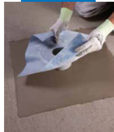
Установка вертикального дренажа на Mapelastic
