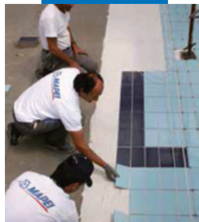
Укладка керамической плитки на Mapelastic в бассейне
