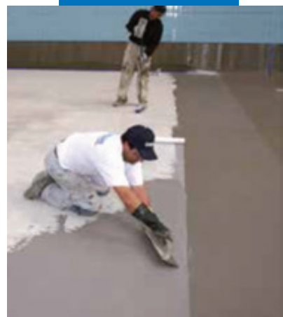
Гидроизоляция бассейна с применением Mapelastic
