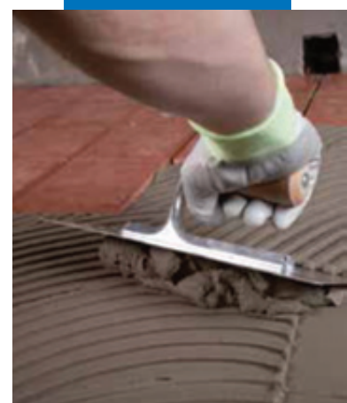
Нанесение Granirapid на гидроизоляцию Mapelastic на террасе
