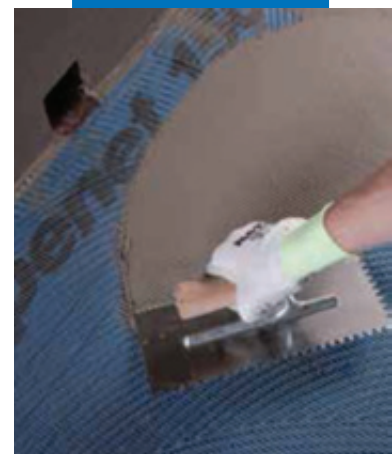
Нанесение Mapelastic на Mapenet 150
